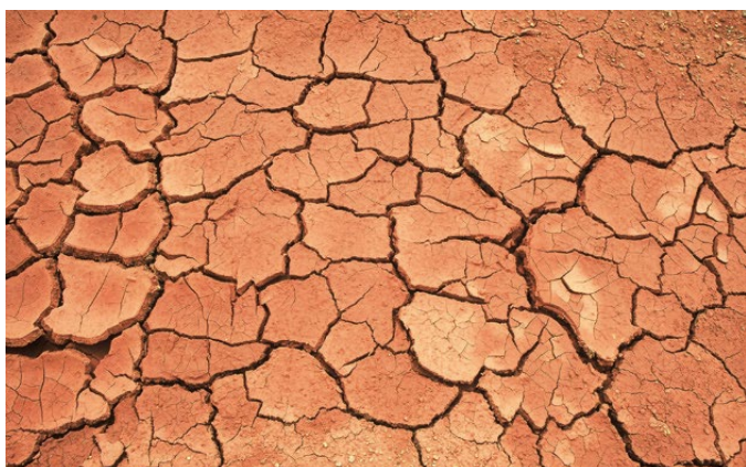
Fig. 4 : fentes de dessiccation sur un sol argileux [6]
