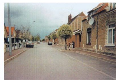
Les structures réservoirs tamponnent les eaux pluviales dans le cœur de la cité. En surface, rien n'est perçu par les riverains.
