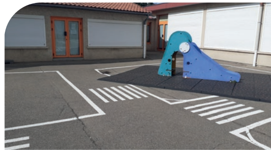
Visite d'une cours d'école en vue de la désimperméabiliser
