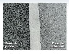
La séparation « poreux - imperméable » permet une gestion simple des eaux pluviales.
