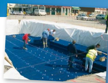
**Ce bassin d'infiltration permet en plus de stocker et d'infiltrer la quasi-totalité des eaux pluviales tombant sur les toitures du bâtiment de la gare et des habitations riveraines. Précédemment le réseau public d'assainissement constituait l'exutoire de ces surfaces.**
