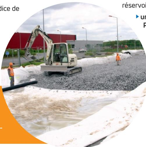
Deux drains sont mis en place dans cette structure réservoir :
