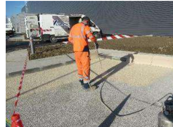
Application finition protection colorée ton pierre
